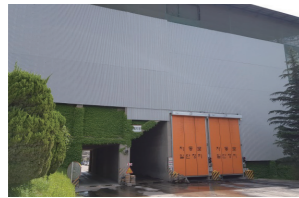
원료 저장고 자동 개폐도어 설치
